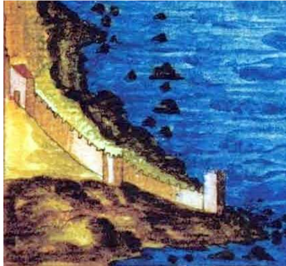
Detalle (Texeira) de la Puerta de la Barrera, muralla y punta del Torrejón.
